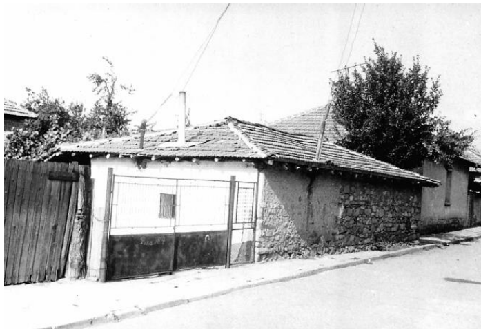
Фиг. 17 Едноетажна, асиметрична къща с помещения за съхранение. В имота са разположени и отделни стопански постройки. Извадка от досието на „Къща на Иван Кръстев“, ПД-0-2-II, свалена от списъка на НКЦ през 1987 г. Обектът съществува към 2022 г., в лошо техническо състояние.
