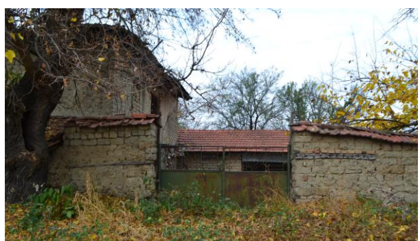
Къща с плевня (комплекс) на ул. Калоферска № 5
