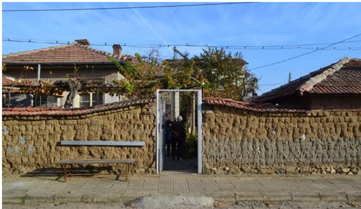
Фиг. 24 Декоративно оформление на ограден зид. Редуване на жълт и сив кирпич, със завършващ ред изпъкнали тухли и покритие от керемиди.
